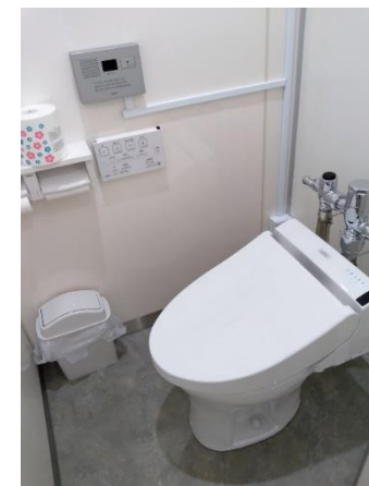
工事後(女性専用トイレ)
