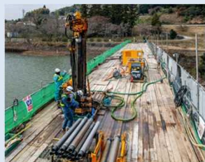
堤体PSアンカー施工状況
