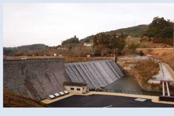
工事完了全景写真 (景観を保持)
