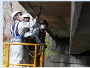
現地点検の実施状況
